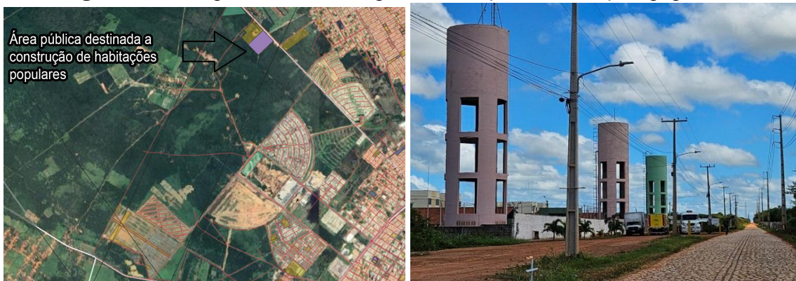
Figura 7 – Área pública destinada para construção de habitações populares
