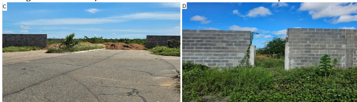
Figuras 16 – Obstruções colocadas nos acessos ao loteamento do Campos do Conde.
