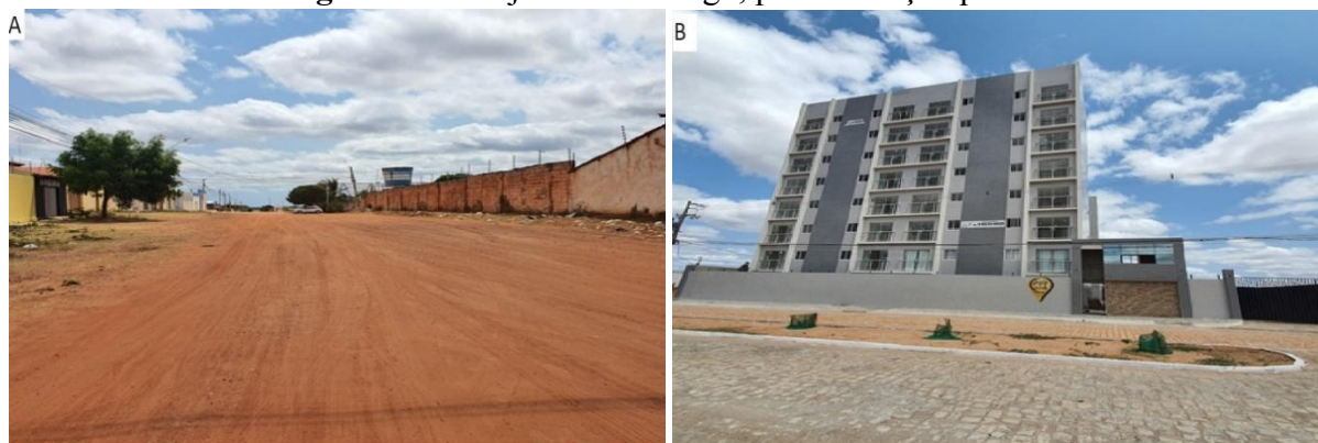
Figura 6 – rua José São do Rego, pavimentação parcial
