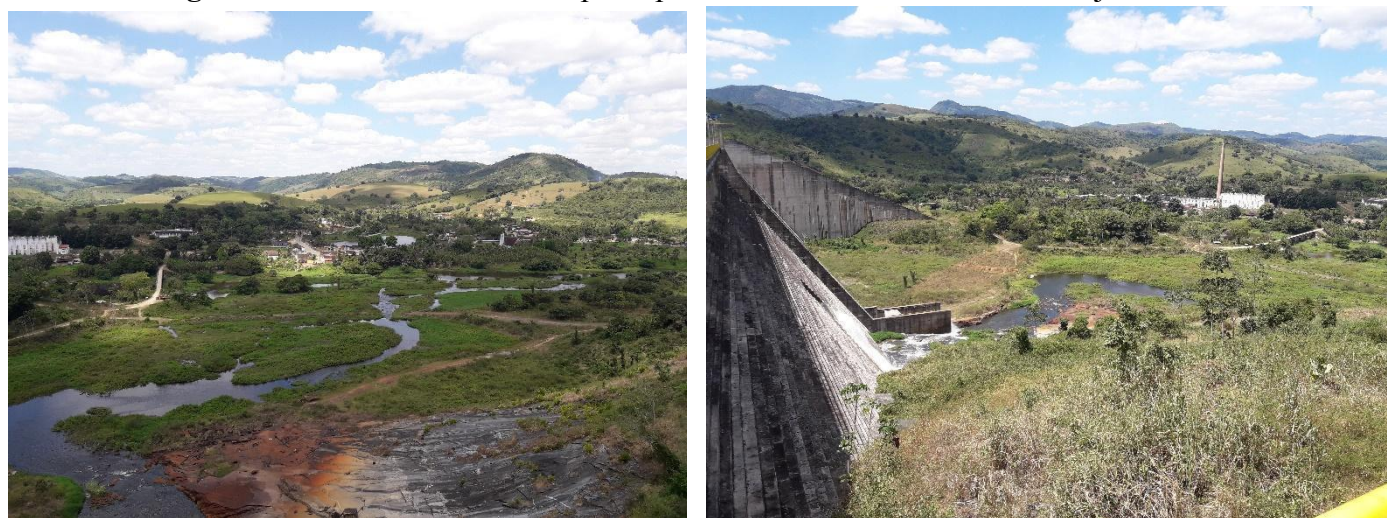
Figura 4 – Visão do barramento principal com o distrito de Serro Azul a jusante.
