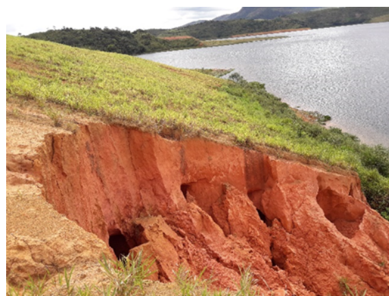
Figura 3 – Processos erosivos nas margens próximas ao barramento principal.
