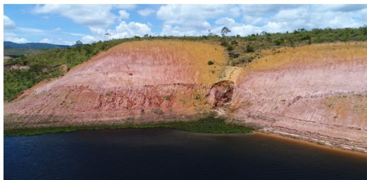
Figura 3 – Processos erosivos nas margens próximas ao barramento principal.
