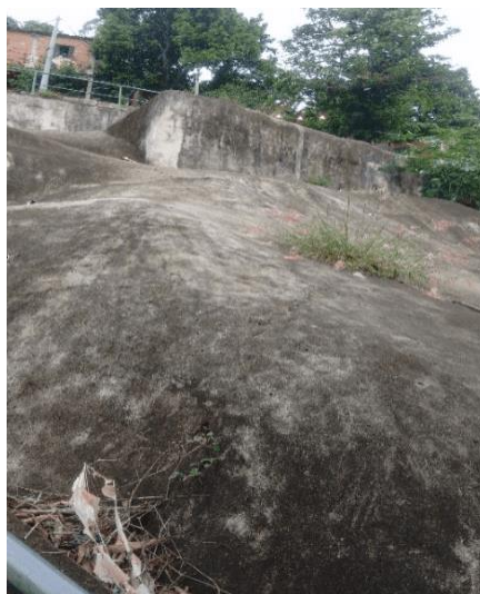
Figura 9. Capeamento de encosta realizado no Parque João Paulo II.
