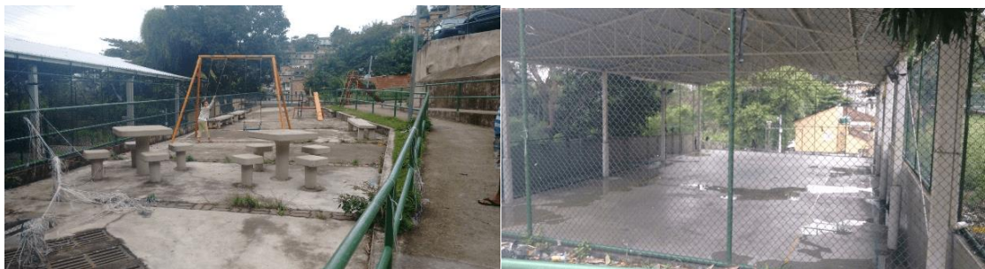
Figura 5. Pracinha (à esquerda) e quadra de esportes (à direita) construídos pelo Programa Morar Carioca.
