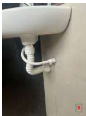
b) Sifão desconectado do ramal de descarga.
