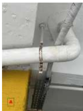
a) Fixação da tubulação comprometida.
