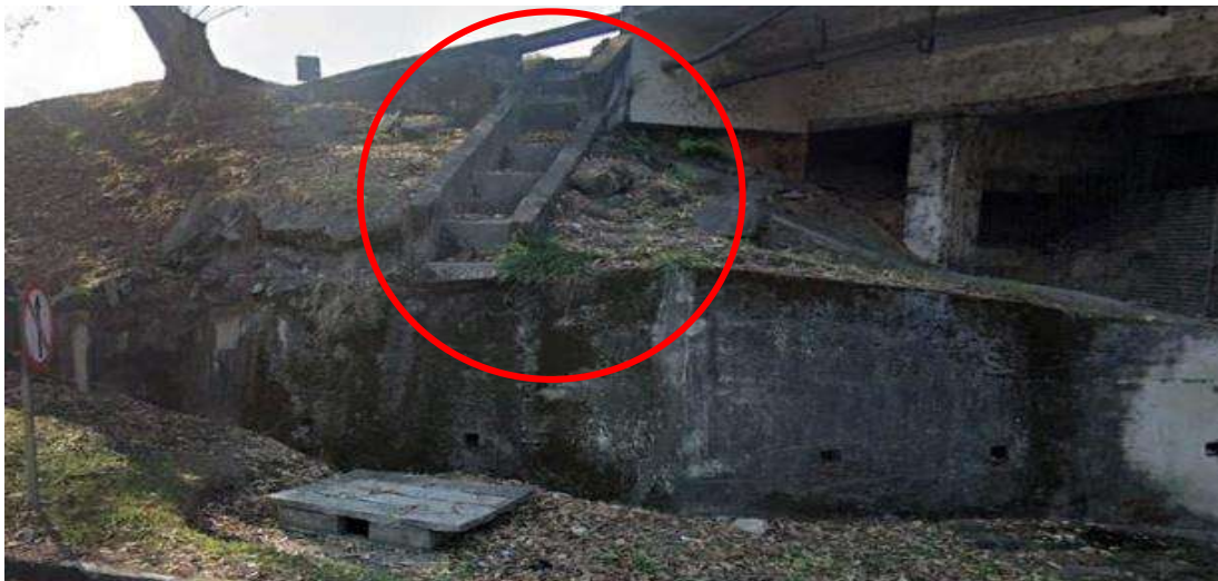
Figura 4. Descida d'Água de Aterro (DAD). Fonte: Elaboração própria.
