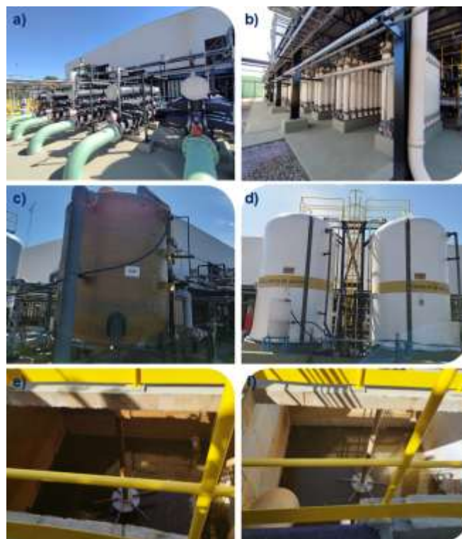
Figura 3. Estação de tratamento de água Lago Norte – ETA Lago Norte, Brasília (DF), Brasil (29/05/2025). a) unidade de pré-filtração (filtro de disco) b) vista dos trens de UF c) tanque de limpeza química das membranas de UF (CIP, do inglês clean-in-place ) d) tanques de armazenamento de hipoclorito de sódio ( \text{NaClO} ) para desinfecção da água ultrafiltrada e) tanque com concentrado de membrana f) tanque com rejeitos da limpeza química.
