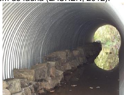
Foto 2: Detalhe da passagem feita com pedras no interior do bueiro metálico corrugado, também utilizado para drenagem – úmido (CALTRANS, 2009).
