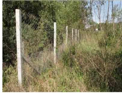
Foto 4: Detalhe da vegetação tomando a estrutura da cerca guia de fauna (BR 386/RS, 13/01/2015).
