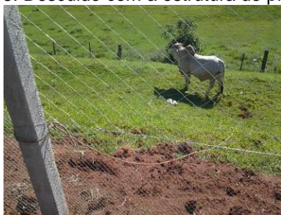
Foto 1: Animal amarrado indevidamente no mourão de concreto que compõem a estrutura da cerca guia de fauna (BR 386/RS, 04/12/2014).
