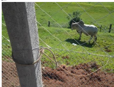
Foto 2: Detalhe da amarração indevida de animal no mourão de concreto que compõem a estrutura da cerca guia de fauna (BR 386/RS, 04/12/2014).
