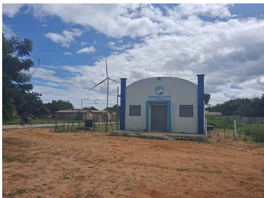
Imagem 4 - Assentamento Guarapes, em Jandaíra (RN).
