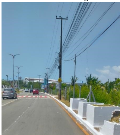
Foto 11 – Av. Euclides Figueiredo
