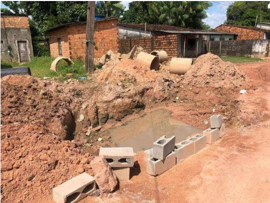
Figura 14. A primeira etapa da obra física que está sendo desenvolvida na Rua Velho Léon, refere-se a instalação da rede de distribuição geral através do assentamento dos tubos de redes de água (Foto: autores, julho de 2022).
