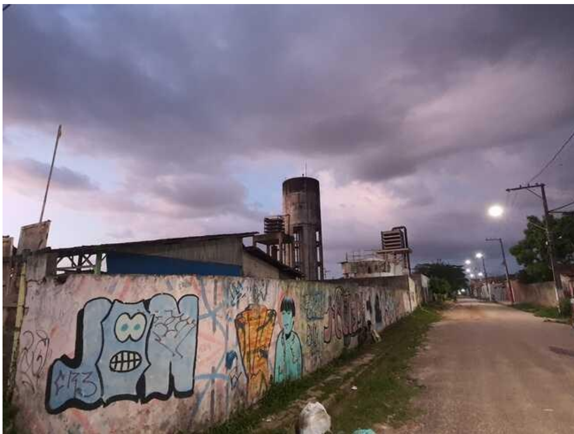
Figura 13. Sistema de abastecimento de água da COSANPA no conjunto Verdejante (Foto: autores, novembro de 2022).
