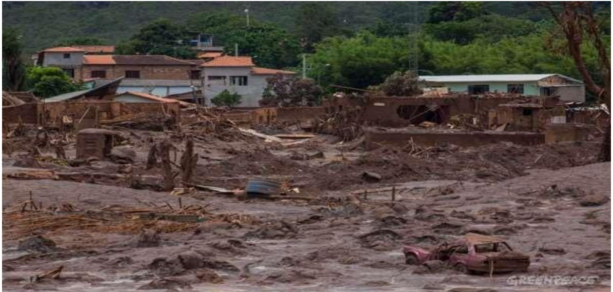
FIGURA 2 – Imagem após o escoamento de rejeitos da barragem de Fundão [Vista do arraial de Bento Rodrigues (@Victor Moriyama/Granpreace)].
