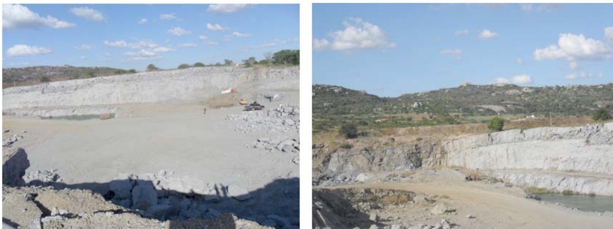
Figura 3: Desmonte de rocha Fonte: Própria, 2011
