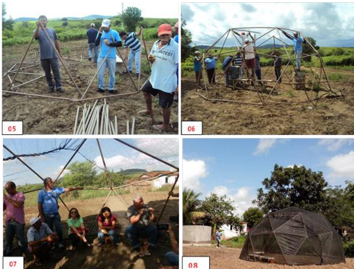
Figuras – 5 a 8: Construção e aplicação da geodésica - UDPAF do PA Margarida Alves I – Juarez Távora
