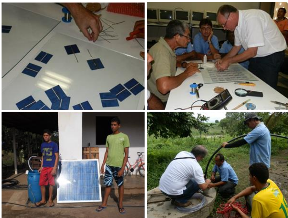
Figuras – 9 a 12: Construção e implantação de painel solar – UDPAF do PA Penha I – Alagoa Grande
