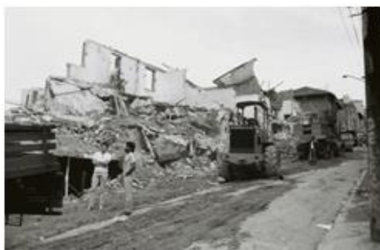
Figura 7 - Demolição das edificações nas ruas Jandaia e Assembleia, em 1987. Fonte: Fotografia de Israel dos Santos Marques. Disponível no portal de Acervos Artísticos e Culturais da Secretaria Municipal de Cultura de São Paulo.
