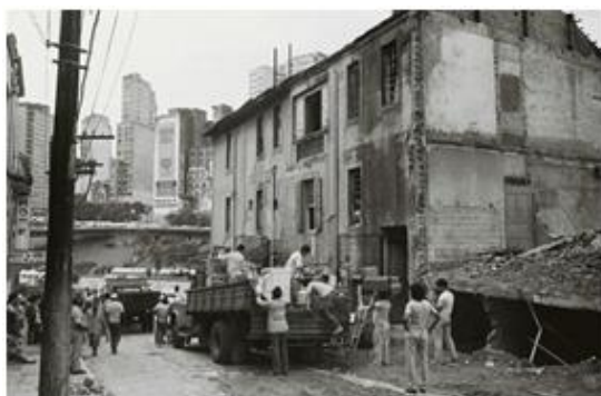
Figura 6 - O processo de desocupação e demolição das edificações nas ruas Jandaia e Assembleia, em 1987. Fonte: Fotografia de Israel dos Santos Marques. Disponível no portal de Acervos Artísticos e Culturais da Secretaria Municipal de Cultura de São Paulo.
