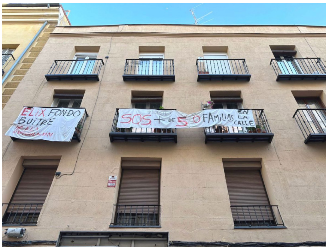
FIGURA 5: Faixas na fachada no Edifício Tribulete.
