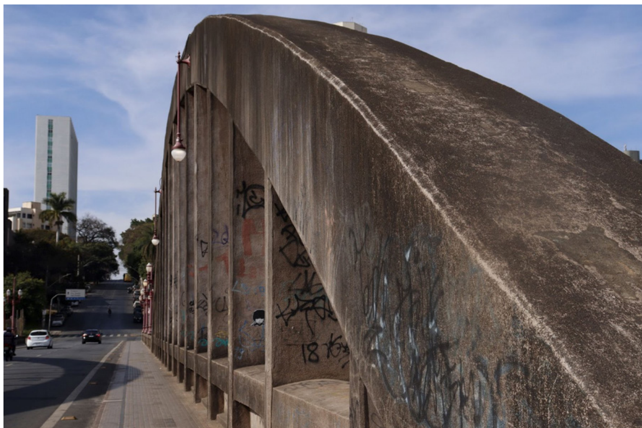
FIGURA 3: Viaduto Santa Tereza
