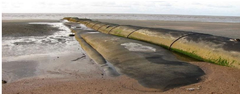
Figura 2. Estrutura de geotêxtil ou espigão “flexível”, 2014.
