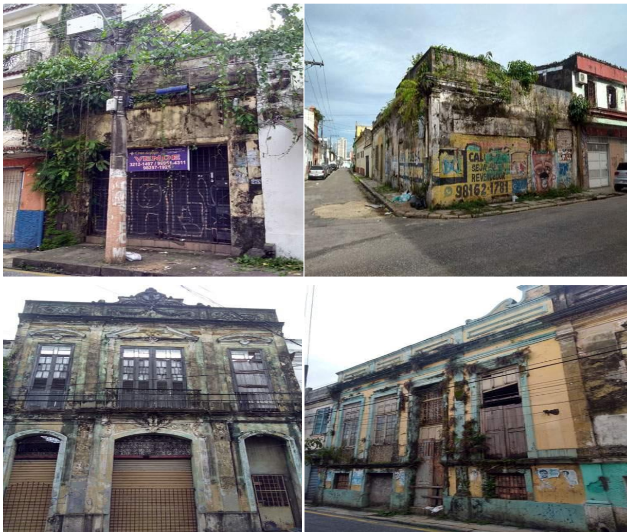
Fotografia 1 - Casa abandonada em estado de ruínas.
