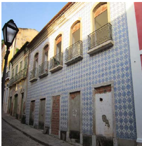
Figura 4 – Imóvel objeto de judicialização, em processo de recuperação, e que abrigará uma escola de música municipal
