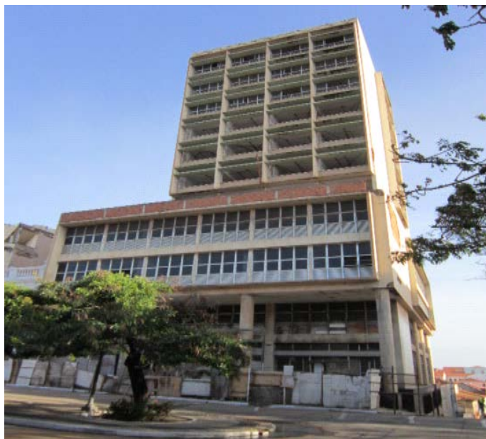
Figura 1 – Edifício João Goulart, construído no Centro Histórico e, atualmente, objeto de judicialização
