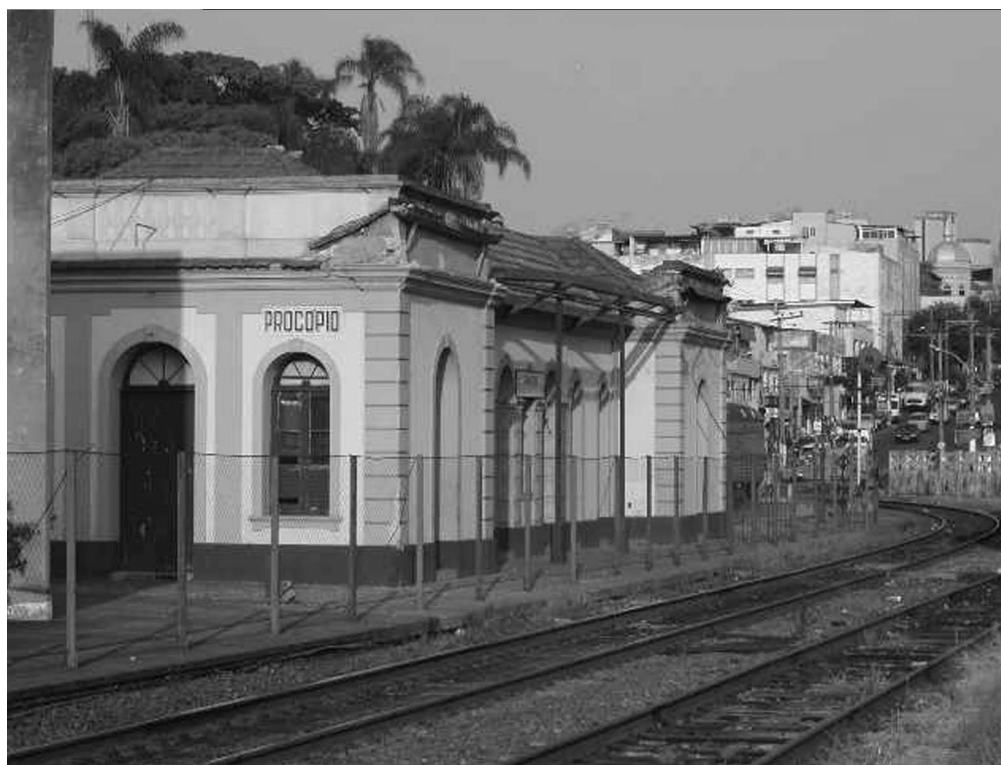
Figura 05 – Vista atual da Estação de Mariano Procópio em estado de arruinamento, já sem o pavilhão em estrutura metálica. Fotografia Raquel Portes, 2005.
