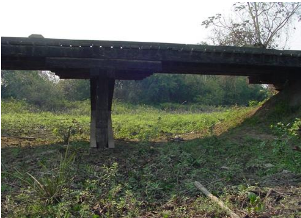
Figura 2. Ponte de Madeira na estrada-parque Pantanal. Fonte: RIBEIRO, M. A. (2018)
