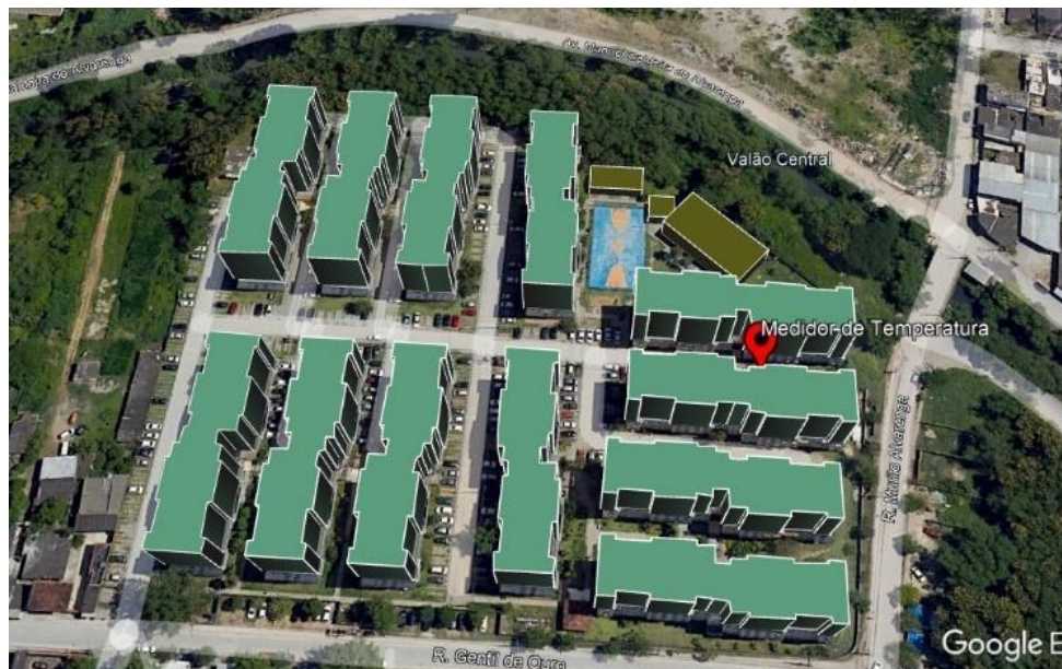
Figura 2. Modelagem 3D do Cond. Jardins de Campo Grande com a localização do medidor de temperatura e umidade do ar em vermelho.
