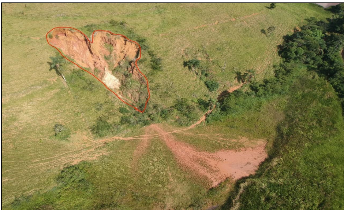
Figura 5. Voçoroca, em área de pasto, no município de Rio Claro (RJ). Pode-se notar semelhança de forma, entre a cicatriz da voçoroca e o material depositado à jusante.
