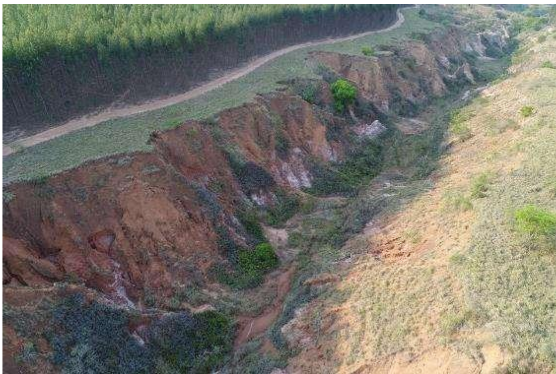
Figura 1. Voçoroca de grande porte em Anhembi – SP
