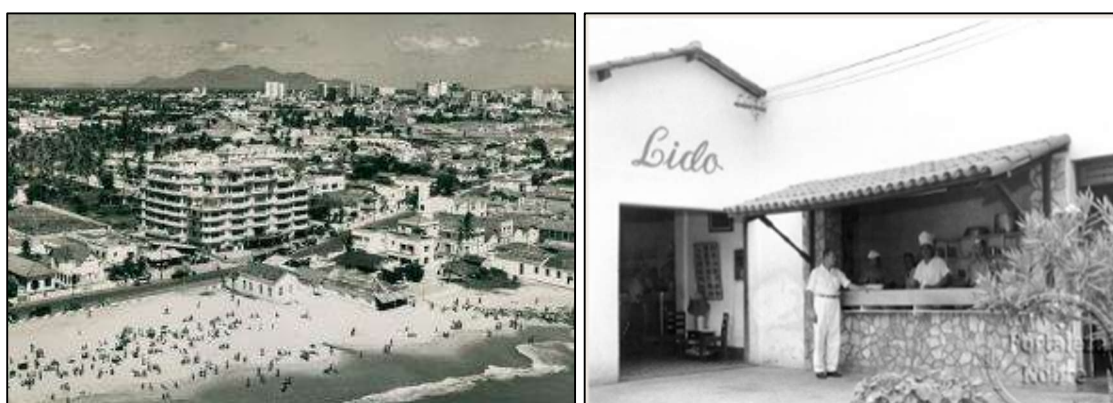
Figura 5 e 6 – Edifício São Pedro e Restaurante Lido na década de 1950
