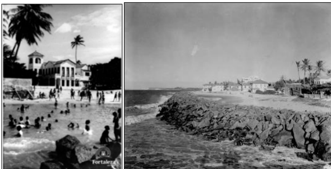
Figura 4 - Piscina formada pelo avanço do mar ao redor da então Vila Morena (hoje Estoril) e quebra-mar construído na Praia de Iracema, em 1952, para atenuar os problemas com a erosão costeira
