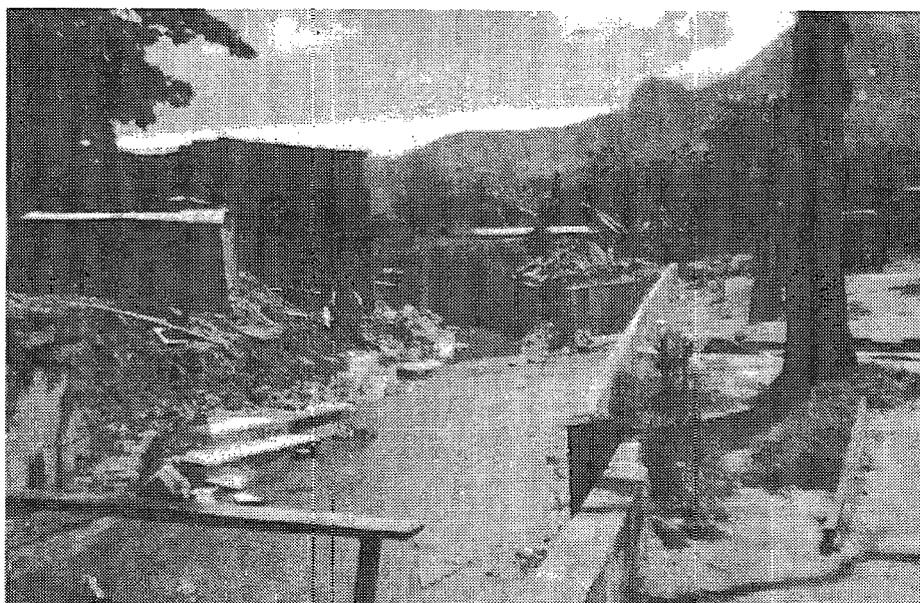
Fotografia 2 - Esta foto, tirada após as chuvas do dia 08 de janeiro de 1998 (Dia 11 de janeiro), mostra a destruição das paredes de contenção no rio Quititi, que foram feitas após as chuvas de fevereiro de 1996. Foto: Edson Soares Fialho. (CLIMAGEO/UFRJ).
