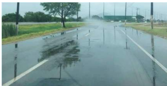
Figura 15 - Banco de areia próximo ao contorno da via e lâmina d'água em dia de chuva
