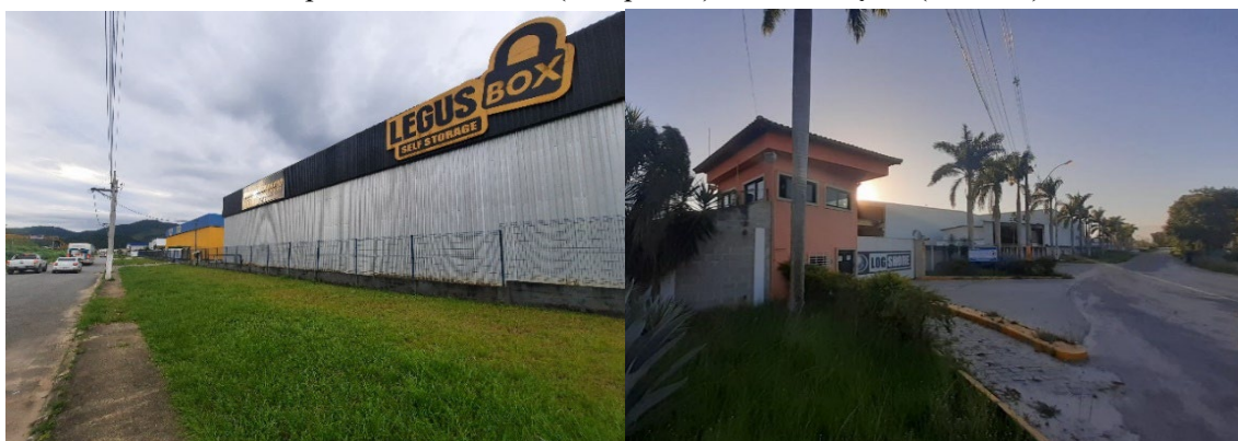
Imagem 1 - Empreendimentos logísticos instalados sob influência do antigo Comperj nos municípios de Rio Bonito (à esquerda) e São Gonçalo (à direita)
