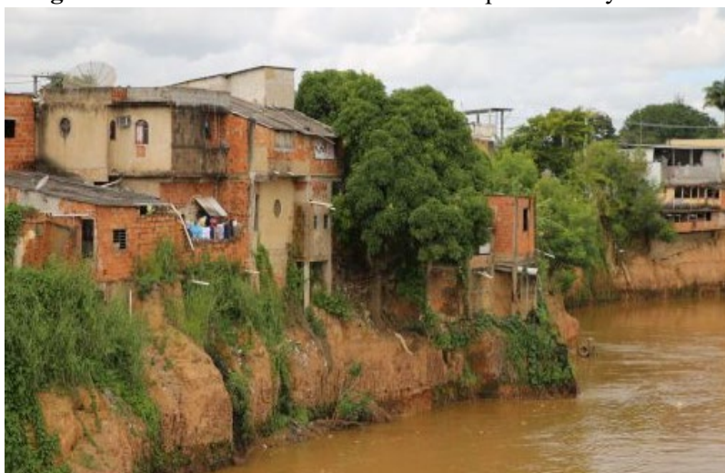
Figura 2 - Casas em área de risco em Campos dos Goytacazes
