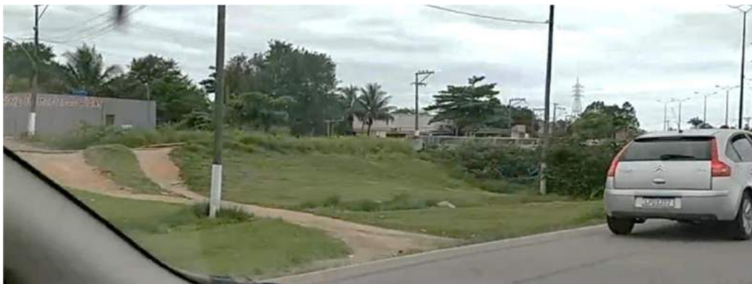
Figura 13 - Cruzamento irregular sobre o canteiro central.
