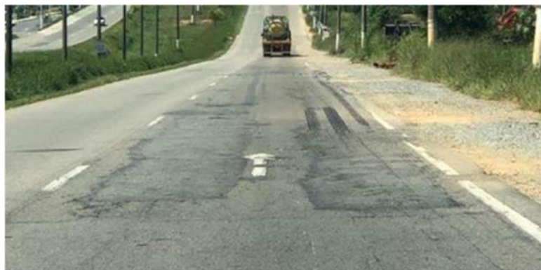
Figura 14 - Pavimento com remendos, trincas e bordas erodidas, além da ausência de acostamento e desnível no bordo da via
