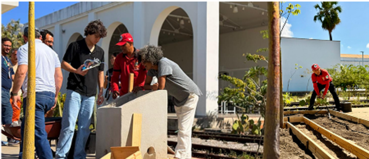
Figura 5 Sessão de instalação de sistema de irrigação no Complexo Cultural Estação das Artes
