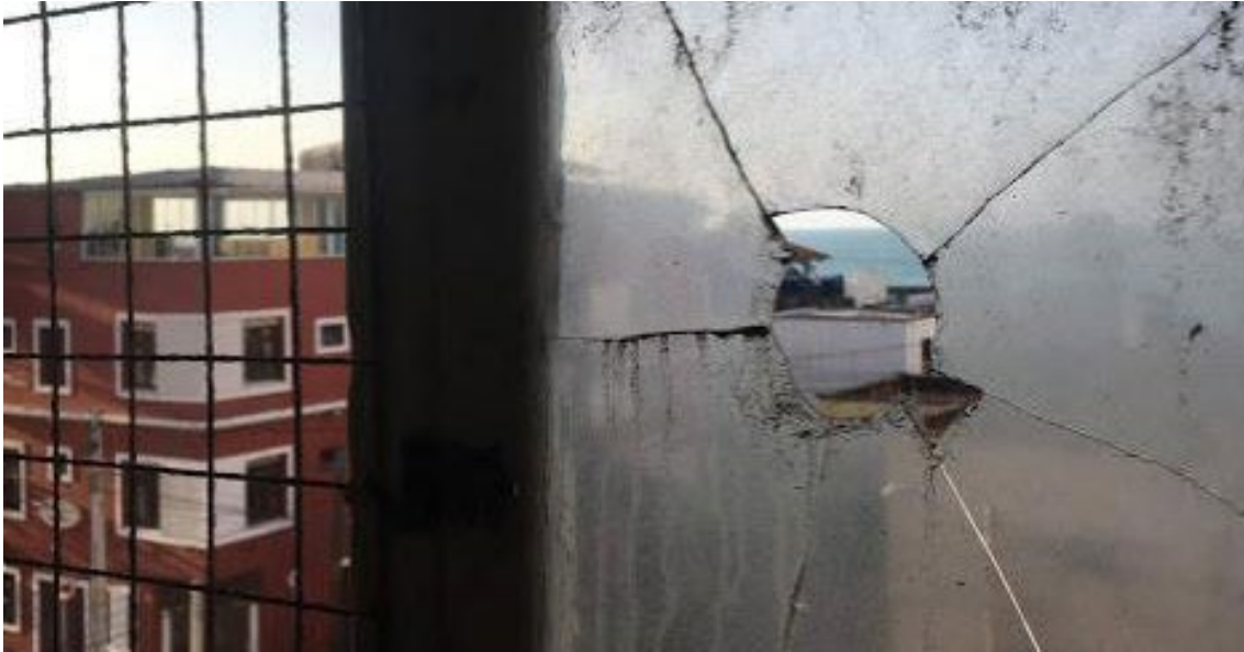
FIGURA 11: Janela do Edifício. Fonte: Arquivo Pessoal
